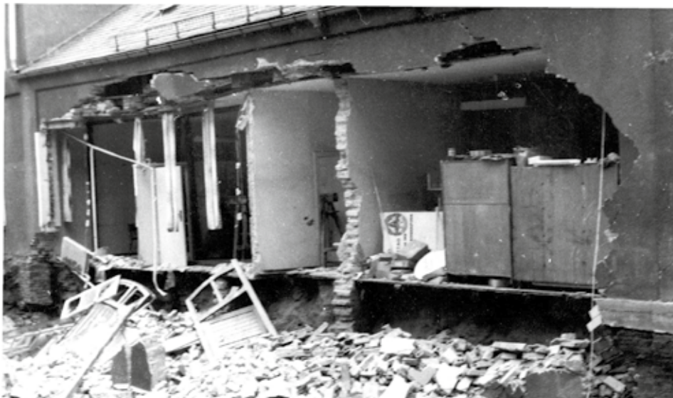
Eine Riesenpanne gab es bei der Renovierung des alten Schulgebäudes zur neuen Arztstation. Für die neuen Fundamente zur Erweiterung wurde Sand abgegraben. Dadurch verlor die Rückwand an Stabilität und stürzte am 15.6.1987 ein. Doch der Schaden wurde behoben und die Arztstation konnte am 1.7.1989 in Betrieb genommen werden.
